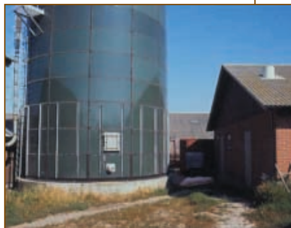
Un impianto per la produzione di bio-gas.
