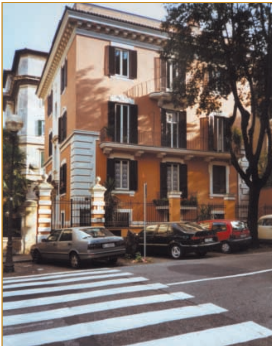
Roma. L'edificio che ospita il centro di assistenza agricola degli Agrotecnici.
