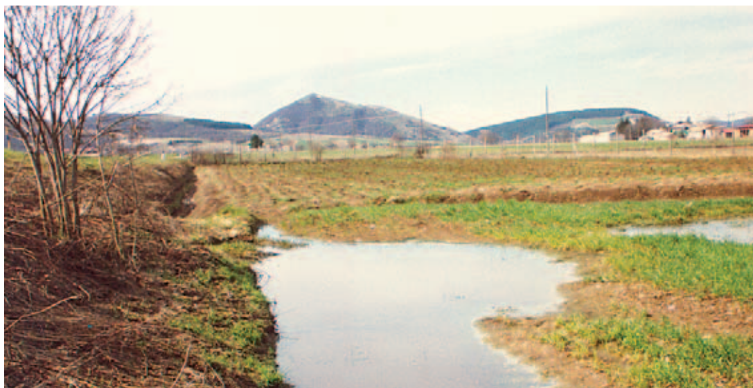
Sopra, baulatura. Sotto, ristagno idrico
